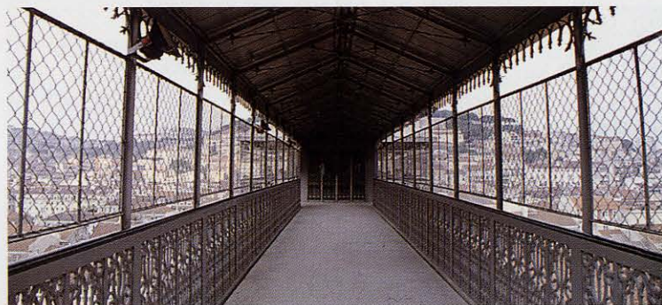
Puente del elevador
